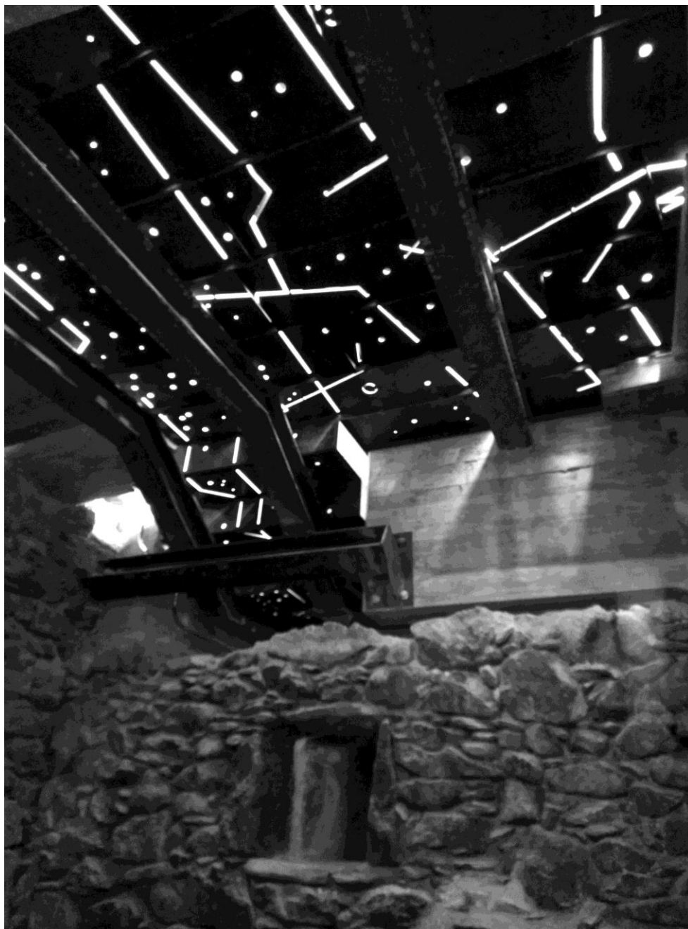
FIGURA 16: Escala interior soterrani (foto: P.A.)
