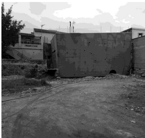
FIGURA 1: Vista exterior ampliació celler Vinyes dels Aspres (foto: R.R.)
