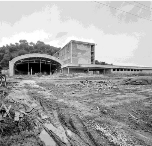
Figura 3 i 4: Vistes de l'edifici abandonat l'any 1972 (NS7711. Arxiu Municipal de Girona).
