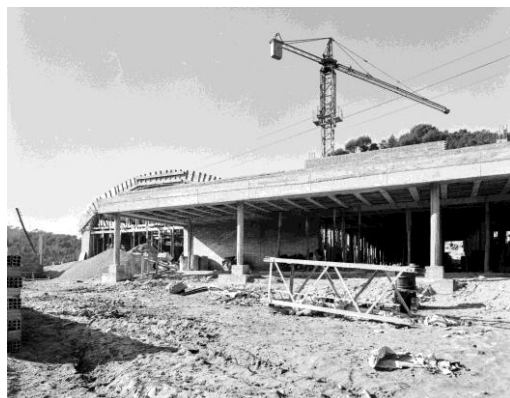
Figura 7: Vista construcció menjador i auditori (1969) (NS7711. Arxiu Municipal de Girona).
